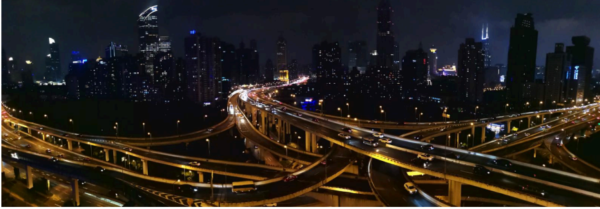
Shanghai, incrocio di sopraelevate tra Chongqing middle road e Yan'an east road, primavera 2018.
