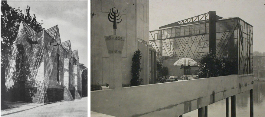
6 | Peter Behrens, Dombauhütte in München, 1922; Glashaus im Österreichischen Pavillon der "Exposition internationale des Arts décoratifs et industriels modernes in Paris, 1925.
