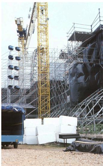
3 | Il retro del palco con la struttura, le torri a supporto dei sistemi di proiezione e alcuni dei mattoni in poliuretano.
