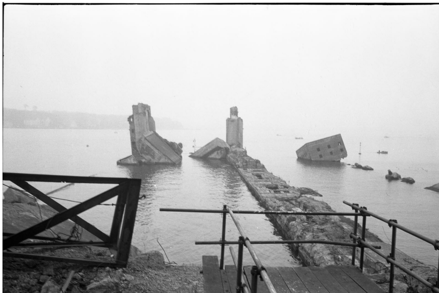
21 | Avanzi dell'U-Bootbunker Kilian, Kiel 1962. Al centro le strutture in elevazione superstiti del portale Ovest. Sulla destra la parte sommitale della Flackturm Est che affiora dal Kieler Förde (fonte: Stadtarchiv Kiel, segnatura: Fotoarchiv 29.181, 24.10.1962, fotografia: Friedrich Magnussen; titolo d'archiviazione: U-Bootbunker Kilian als Ruine ).
