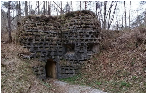
20 | Ingresso principale al bunker.
