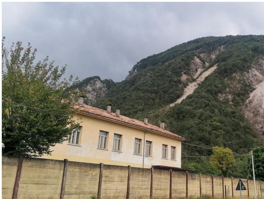
3 | Dissesto idrogeologico a destra e a sinistra caserma dismessa in località Carnia.
