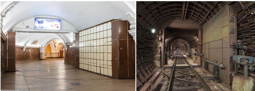
35 | La porta ermetica decorata della stazione Komsomolskaja e una porta ermetica che seziona un tunnel metropolitano. Notare in quest'ultima i meccanismi che permettono la sigillatura delle rotaie.
