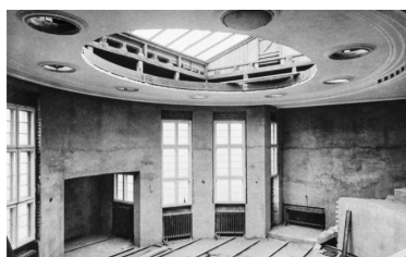
4a | Construction de la salle elliptique, c. 1925.
