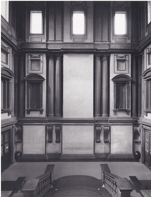
5-7 | Miguel Ángel. Ricetto de la biblioteca Laurenciana, 1524-1559, Firenze, muros este y oeste; muro sur con la puerta de entrada a la biblioteca; muro norte con el paño ciego.
