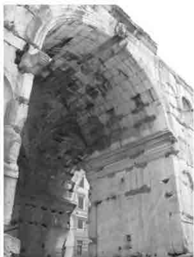
Arco di Giano. Dettaglio della volta
