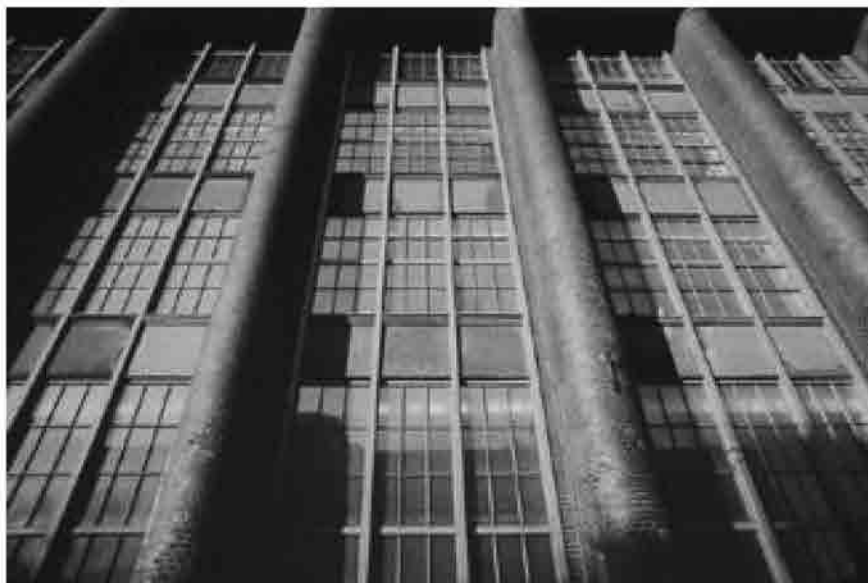
Kleinmotorenfabrik, fronte sud .
