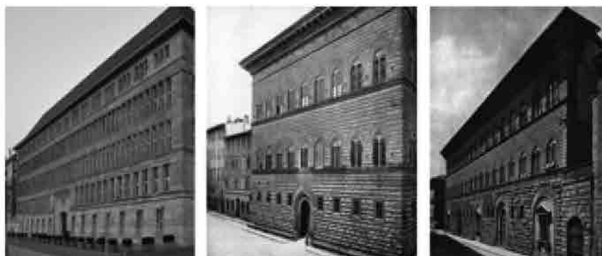
Da sinistra a destra: Edificio amministrativo Mannesmann, Düsseldorf, 1910-1912: veduta; Benedetto da Maiano (Giuliano da Sangallo), Palazzo Strozzi, Firenze, 1489-1538; Michelozzo, Palazzo Medici Riccardi, Firenze, 1444-1452 (Archivio Alinari).
