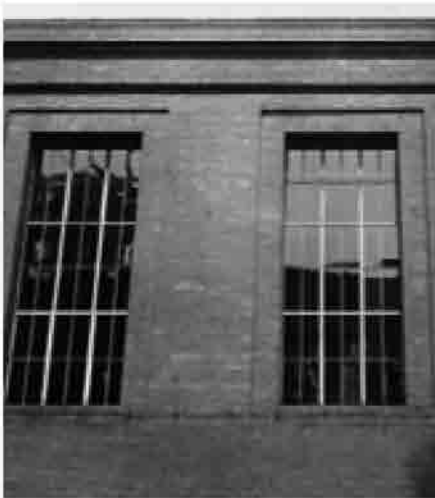
Behrens, Frankfurt-Osthafen, Frankfurter Gas Works, 1910-12.
