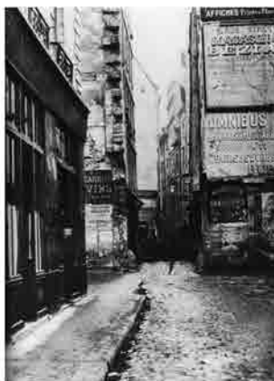
vignetta che raffigura il Barone di Haussmann nei panni di distruttore e al tempo stesso di costruttore; Charles Marville, Rue du Jardinnet , Paris
