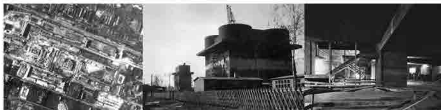
Il Flakbunker di Wilhelmsburg in costruzione, 1943.
