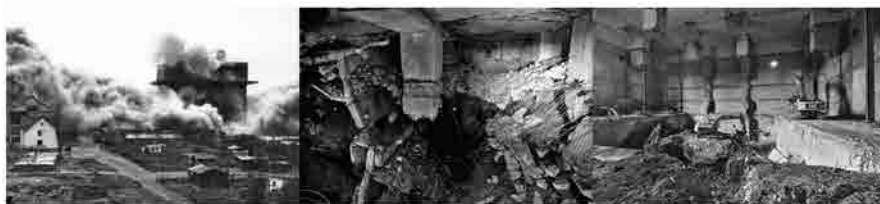
L'esplosione controllata del 17 ottobre 1947 per rendere il Flakbunker di Wilhelmsburg inagibile. Le macerie all'interno del bunker prima del restauro. Il bunker liberato dai detriti, pronto per accogliere il nuovo progetto. Si noti come i pilastri distrutti dall'esplosione rimangono appesi al solaio blindato della copertura.
