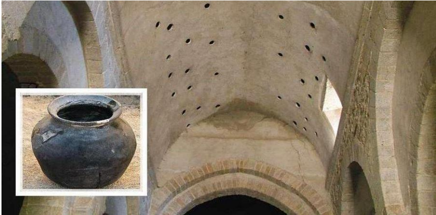
1 | Vasi acustici nella volta della chiesa di Pommiers en Forez in Auvergne (France), fonte Valière, Palazzo-Bertholon, Polack, Carvalho 2013, 75.
