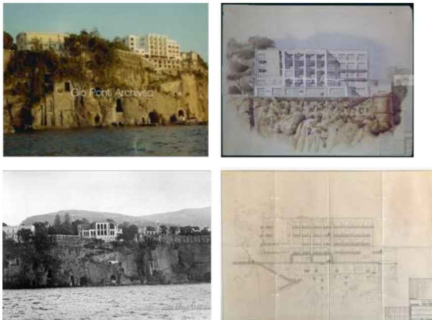
13 | Studio Ponti, Fornaroli, Rosselli, Hotel Parco dei Principi , Sant'Agnello, 1960-1964, fronte nord dell'albergo: foto dell'opera realizzata e studi; in basso a sinistra la dacia non finita, voluta dalla principessa Corcthacova, prima di essere sostituita dalla nuova architettura di Ponti. Fonte: Gio Ponti Archives.
