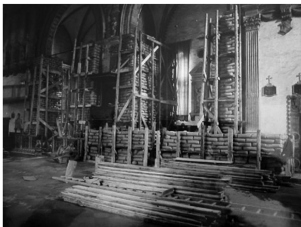
Protezioni antiaeree del Tempio Malatestiano all'esterno e all'interno dell'edificio
