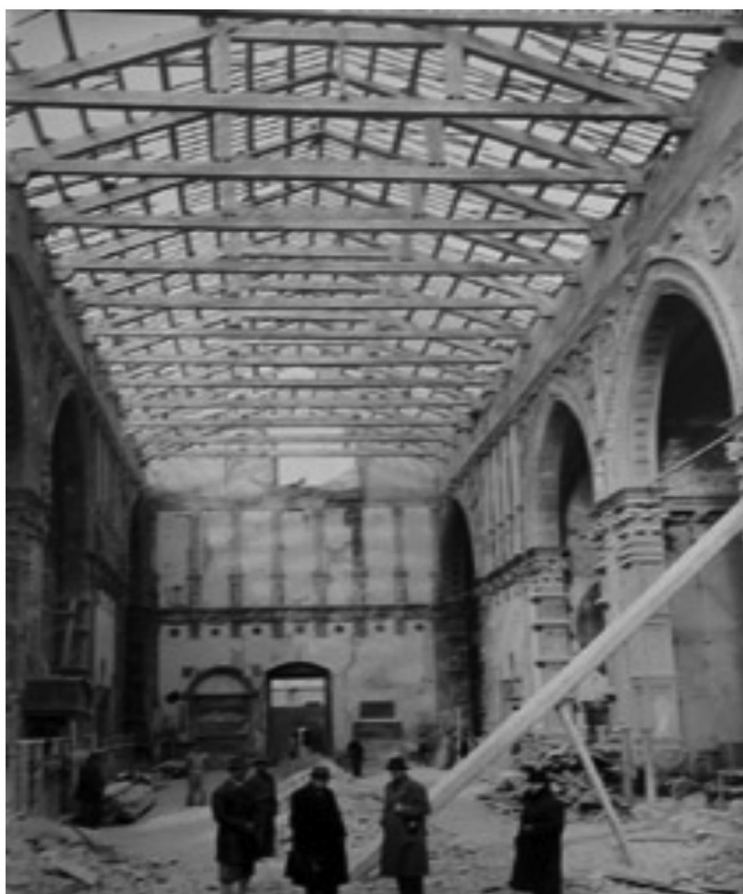
Lavori di restauro al fianco destro del Tempio; un sopralluogo nel corso dei lavori
