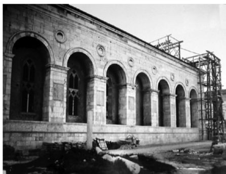
Il fianco sinistro dopo il rimontaggio dei conci
