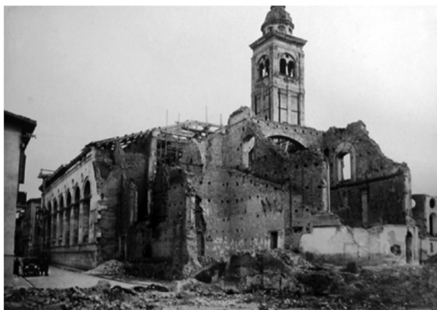
Il Tempio Malatestiano dopo i bombardamenti: sconnessione delle protezioni antiaeree in facciata; la zona absidale distrutta
