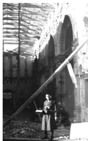
Bombardamenti al Tempio Malatestiano: distruzione delle coperture e primi rilievi dei danni
