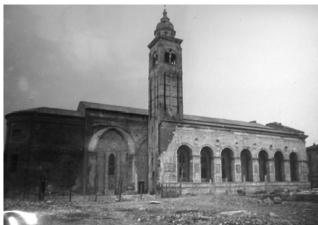
Interventi di restauro sulla parte absidale e lungo il fianco sinistro del Tempio
