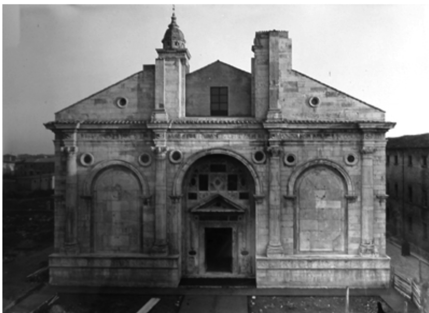
Fornice e facciata del Tempio Malatestiano smontati e rimontati
