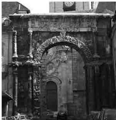
con altrettanti risalti l'aggetto delle membrature verticali, risalti che, per l'intera ampiezza del fornice, si raccordano in un unico tratto di trabeazione sostenuto in mezzera dalla possente chiave dell'archivolto.
