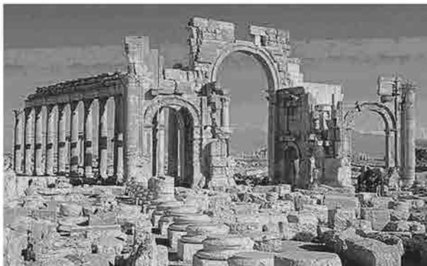
d.C.), quale raccordo o cerniera, un arco trasversale a tre fornici di pianta triangolare, con apertura tra i lati di trenta gradi. Nei due fronti, nati dallo stesso vertice ma via via divergenti per disporsi trasversalmente e perpendicolarmente agli assi ruotati della strada, le aperture minori riservate ai pedoni si inserivano nei portici d'ambo le parti, mentre il passaggio centrale dominava con la singolare altezza del proprio fornice il traffico dei carri.
